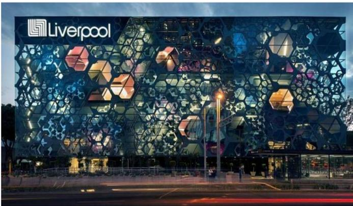
该大楼设计师在设计之初，考虑到厚厚的墙壁会让人视线变得狭窄，也感受不到外面的都市风景。但与其建造一个即很薄的实墙，不如反而是将墙壁加厚，并将其掏空，创造出外观空间，恰恰是这样的一个设计，让整个建筑变得如此与众不同。建筑采用了漂浮的盒子形式往外悬挑，悬挑挑出近3米，创造室内外的缓冲空间，建筑表皮由六边形蜂窝状框架组成，大小蜂窝状空洞大小不一，形成疏密有致的蜂巢结构。
