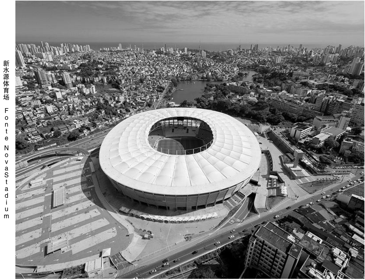
新水源体育场位于巴西萨尔瓦多,于 1951 年 1 月 28 日开放,2007 年 11 月关闭,三年后拆除。2010 年新球场在旧址上修建,取代原有水源体育场。新水源体育场建筑高度 35 米,长 250 米,看台的南部有一个大型开口。这一开口不仅使体育场内空气流动,同时也使体育场与附近的内城湖泊有了直接的关系,为球场带来了新的空气流通。新水源体育场屋盖为索膜结构,屋盖悬挑 63 米,替代原来悬挑 30 米的屋盖。屋盖索膜结构失高最高 19 米。屋盖膜结构位于上下应力环之间,屋面采用由聚四氟乙烯纤维制造的 PTFE 膜材料,面积 301399 平方英尺。
