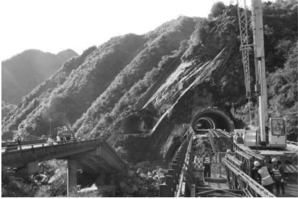
9月上旬起, 陕西境内强秋汛天气造成多地岩土含水饱和, 部分地区因山洪、滑坡、崩塌等地质灾害出现灾情。9月16日9时24分, 由于遭受连续强降雨袭击, G65包茂高速小河至安康段安沟隧道北口, 突发大面积山体滑坡, 造成该路段安康至西安方向罗羌湾大桥约30米桥梁垮塌。西康高速承载车流量大承担的交通任务繁重, 抢险工程必须限时完成。
