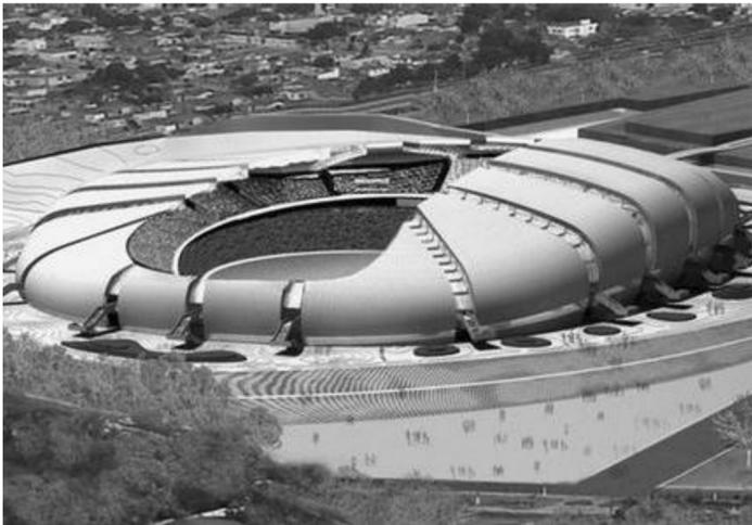
沙丘球场建筑长271米,结构高度47.1米,由20个巨大的蒙铝板的铝制钢架结构组成。高低不对称造型类似于该城市附近常见的流动沙丘。花瓣结构采用钢桁架结构形式,外部蒙铝板,起到隔绝热量和声音的作用。内部采用预应力的聚氯乙稀 PVC 膜覆盖。各个花瓣间的空隙采用半透明的聚碳酸酯材料覆盖,使得体育场具有良好的采光。
