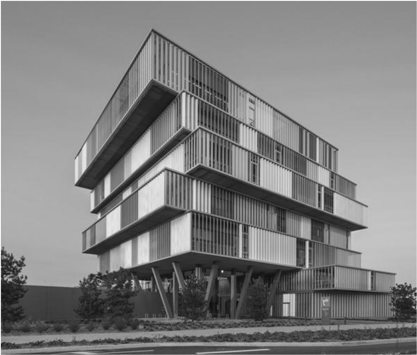
该大楼由一层层的基本体块摞叠而成,微妙的层次感和错位共同创造了不平衡感,似乎无视重力法则,突出了项目强烈的象征意义成为波多尔的一栋标志性建筑。该建筑在外形上采用了错层建设,这一风格为该城市单一的建筑设计风格带来了新气息。
